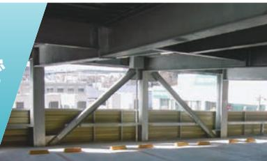
合成スラブを用いた鉄骨構造の床版を多くの柱が支えるシンプルかつ頑丈な構造が、地震に対する強さを発揮しました。
