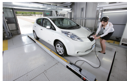
機械式立体駐車場でのEV充電施設
