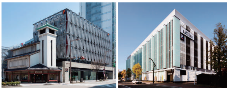
施設併用型駐車場の建設事例
