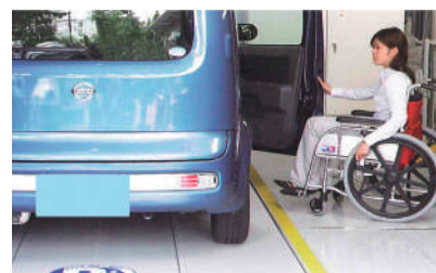
機械式駐車場での車いす利用者対応（フルフラット化）
