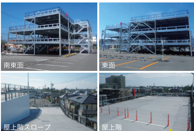
SBS マイホームセンター津波避難施設兼用駐車場
