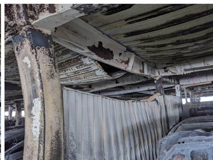
建物外観(火災後) 火災後の柱、梁、天井の状況
