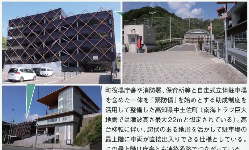
町役場庁舎や消防署、保育所等と自走式立体駐車場を含めた一体を「緊防債」を始めとする助成制度を活用して整備した高知県中土佐町(南海トラフ巨大地震では津波高さ最大22mと想定されている)。高台移転に伴い、起伏のある地形を活かして駐車場の最上階に車両が直接出入りできる仕様としている。この最上階は庁舎とも連絡通路でつながっている。
