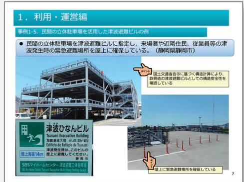
2017年7月の内閣府の技術的助言により、安全性確認の上で鉄骨造の建物も津波避難ビルとして指定可能に。同時に発出された「津波避難ビル等に係る事例集」では自走式立体駐車場が一例として掲載された。
