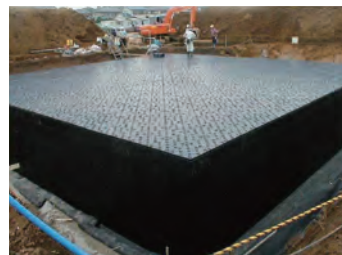
■自走式駐車場地下への貯留槽埋設事例
