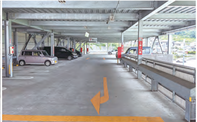
2層3段型自走式立体駐車場に210台を収容する。敷地内駐車場は108台分増えたことになり(160台→268台)、駐車場不足を大幅に解消した。
