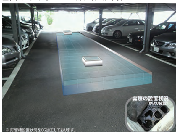
■自走式駐車場地下への貯留槽埋設事例
