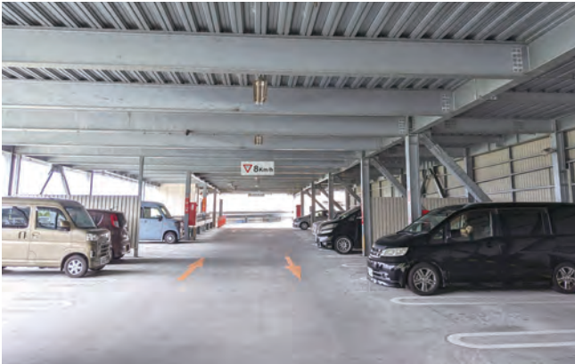
2層3段型自走式立体駐車場に210台を収容する。敷地内駐車場は108台分増えたことになり(160台→268台)、駐車場不足を大幅に解消した。
